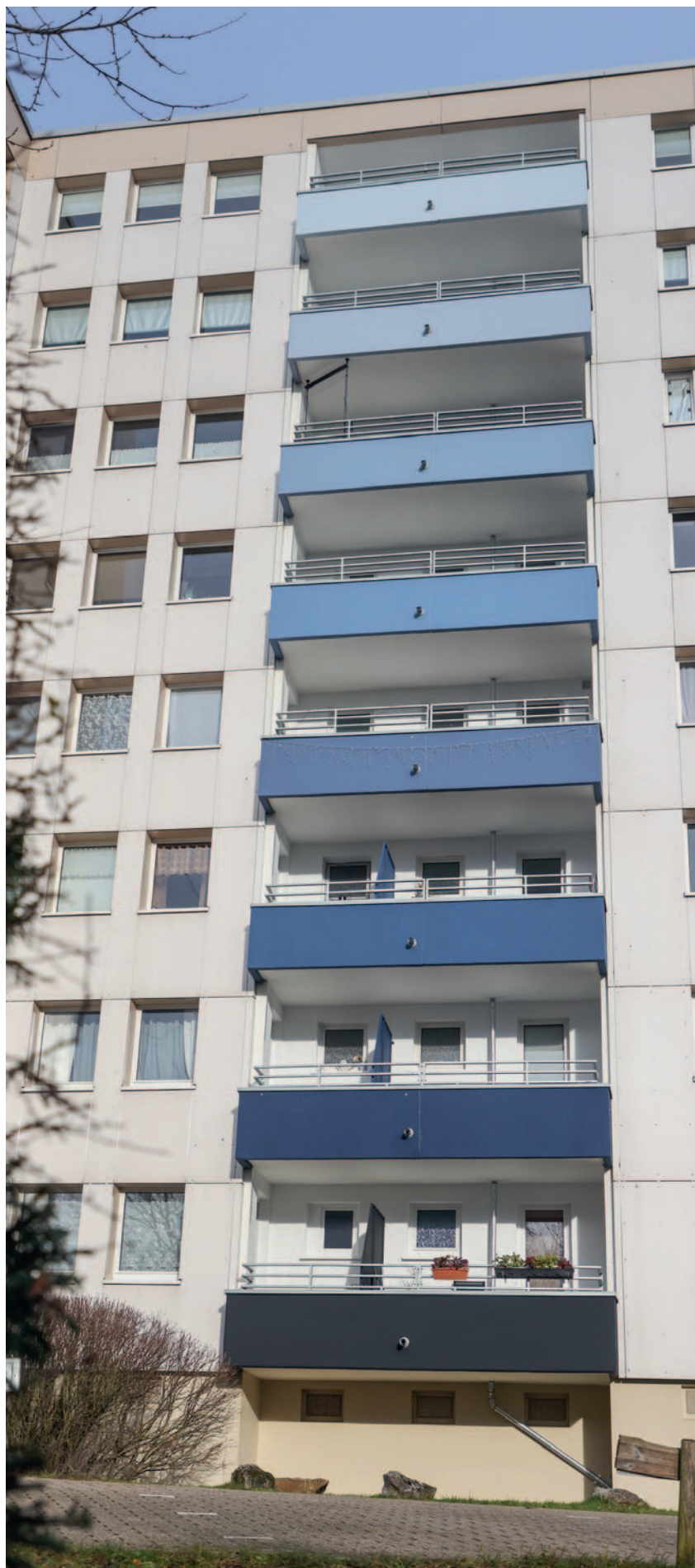
Sanierte Balkone an der John-F.-Kennedy-Straße
