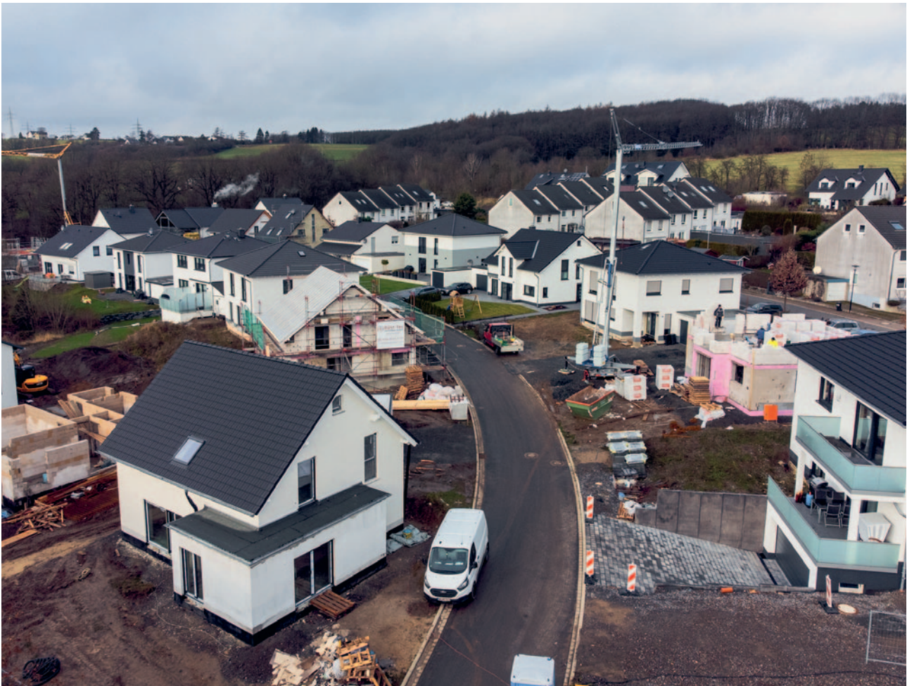
Baufortschritt am Brunnenhof
