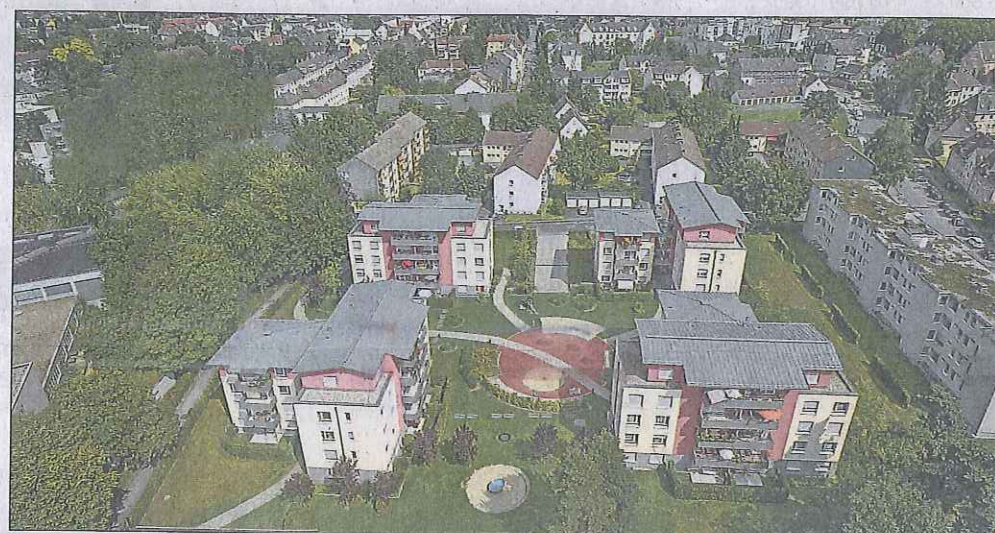
Das Wohnquartier an der Holthausstraße ist die letzte große Neubaumaßnahme der Genossenschaft. Die 56 Mietwohnungen sind mit Fußbodenheizungen ausgestattet, die von Luft-/Wasserwärmepumpen versorgt werden. (Foto: Bernd Henkel)
