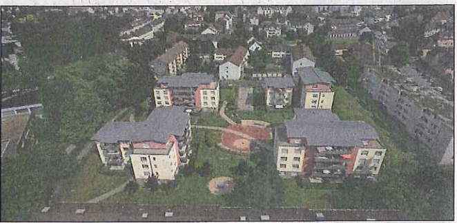
Das Wohnquartier an der Holthausstraße ist die letzte große Neubaumaß- nahme der Genossenschaft. Die 56 Mietwohnungen sind mit Fußbodenhei- zungen ausgestattet, die von Luft-/Wasserpumpen versorgt werden.
